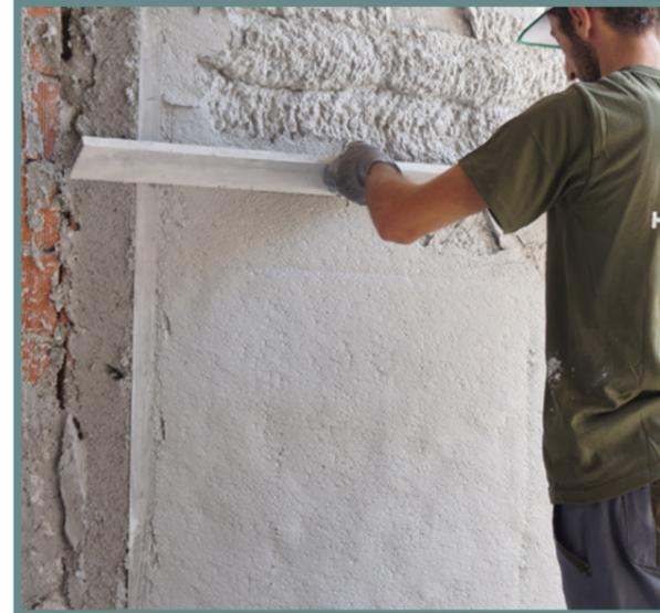
Uygulama işlemi bittikten sonra bıçak mastarı ile mastarlanır.
