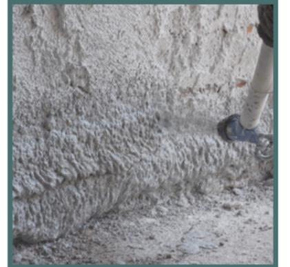
Karışım anoların arasına sıva püskürtme makinesi ile uygulanır.
